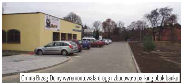
Całkowity koszt przebudowy drogi wyniósł 2 mln zł
